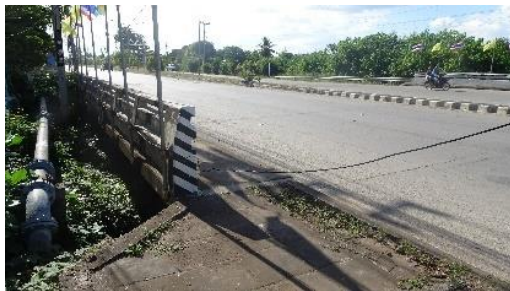
สภาพทั่วไปบริเวณสะพานข้ามคลองตะกุดจั่น
