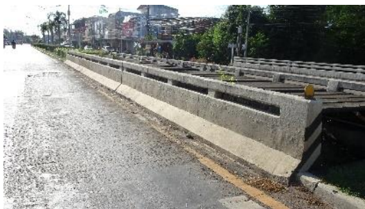
สภาพทั่วไปบริเวณสะพานข้ามคลองปอ
