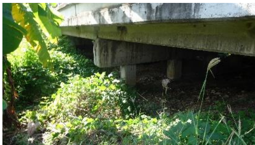
สภาพทั่วไปบริเวณสะพานข้ามลำรางสาธารณะ
