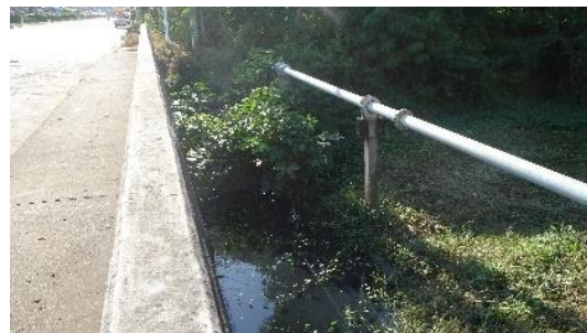
สภาพทั่วไปบริเวณคลองปอ
