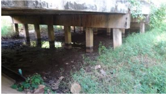
สภาพทั่วไปบริเวณสะพานข้ามคลองตะกุดจั่น 2
