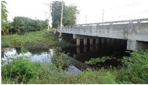
สภาพทั่วไปบริเวณสะพานข้ามคลองหินลาด
