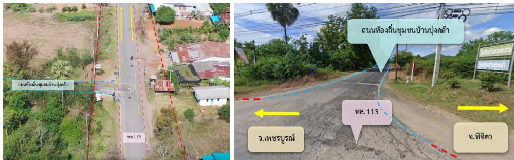
สภาพปัจจุบันจุดตัดถนนท้องถิ่นชุมชนบ้านบึงคล้า บริเวณ กม.49+435 (แยกโรงเรียนหนองระหมาน)
