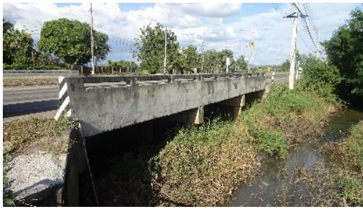
สภาพทั่วไปบริเวณสะพานข้ามคลองบุษบง
