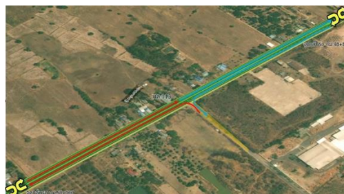
รูปที่ 5-14 จุดตัดที่ 7 แยกถนนเข้าชุมชนบ้านบึงคล้า บริเวณ กม.49+435 ตัดกับถนนท้องถิ่นชุมชนบ้านบึงคล้า
